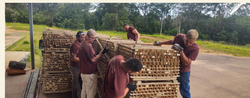
Preparação e montagem de componentes.
