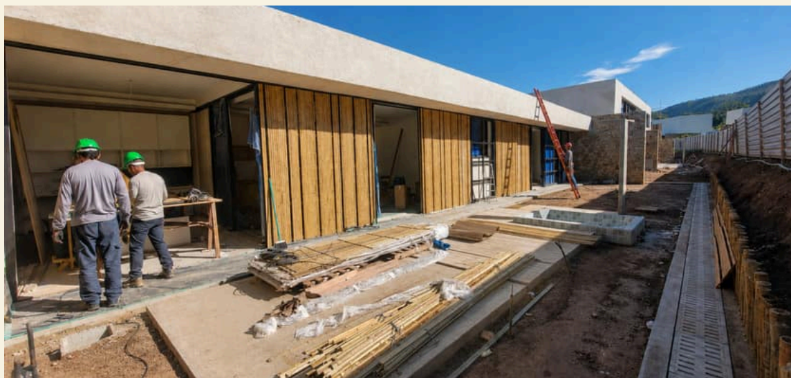
InCasa Residence. Aplicação de painéis de bambu em unidade residencial.
